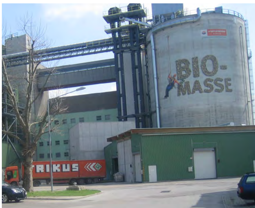
Slika 5: Silos sa vertikalnim transporterom i prihvatnim jedinicama
